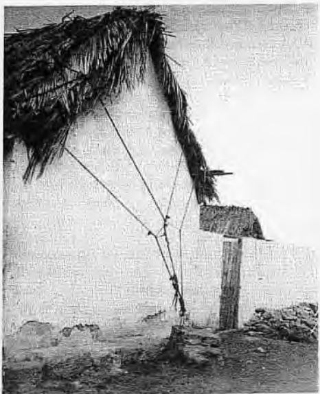
Com tirantes de corda, abraçando os telhados, os moradores precatam-se contra as «brisas» ciclônicas que tudo levam pelo ar – até as coberturas de casas!
