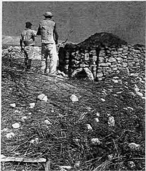
Em forno apropriado, com ostras e conchas queimadas, fabrica-se cal para as paredes de alvenaria.
