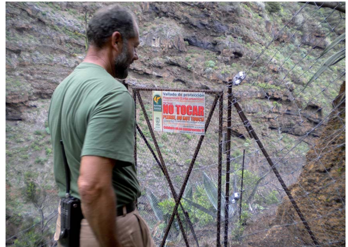
Colocación del vallado de protección y señalización en el roque de La Viña.
