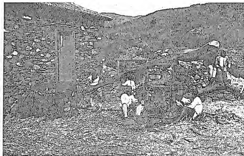
Fig. 7. — Un moulin primitif pour le broyage des Cannes à sucre à Santa Catharina (S. Thilago).
